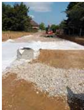
Fin du drainage en galets
