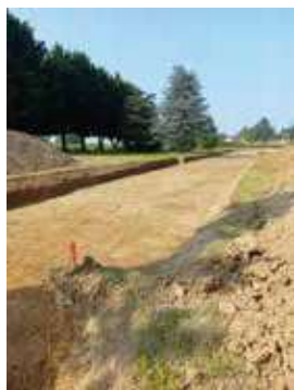
Préparation de la plateforme de la chaussée
