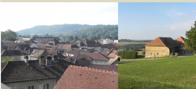
Toitures dauphinoises à La Tour du Pin et ferme en pisé à Doissin
